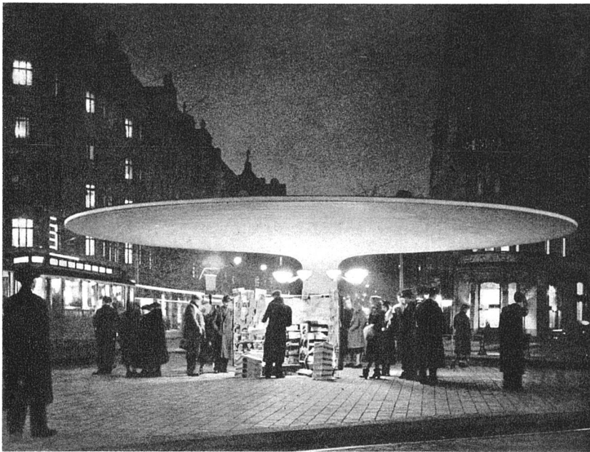
Regenschutz und Verkaufsstand für Zeitungen auf dem Stureplan. Material: Schalungsroher Beton, unterhaltsfrei. Grösster Effekt durch kleinsten Platzaufwand.
