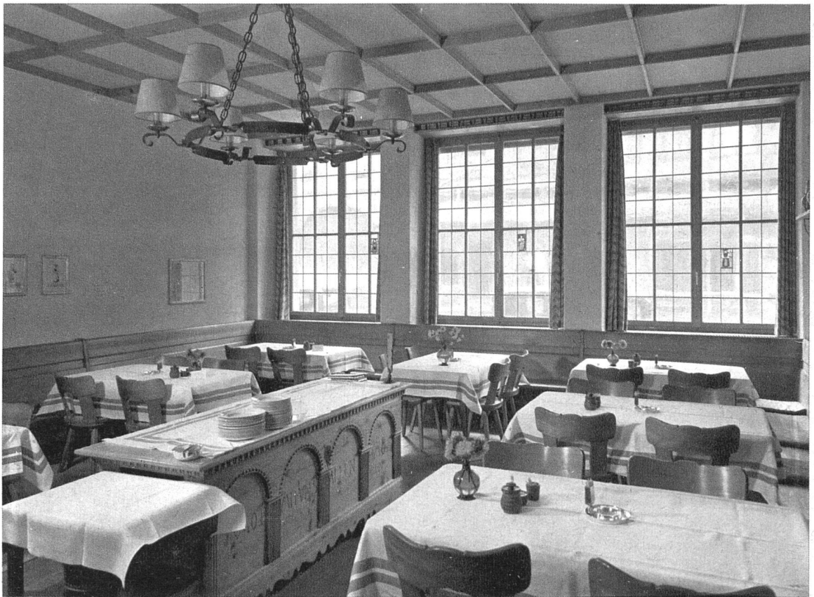
Weinstube neben dem Café. Boden hellrote Tonplatten. Helle Wände mit grobem Abrieb. Bänke und Deckenteilung in gebeizter Esche. Die Fenster mit Antikverglasung mit Bleisprossen, Glasbildchen von Otto Staiger. Ueber den Fenstern die Ventilation-Zuluft-Düsen. Vorhänge in grün, rot, beige zickzackgestreift. Alte Bündnertruhe als Anrichte. Schmiedeeiserner Leuchter mit Messing und Papierschirm
