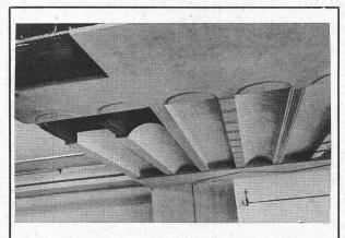
Monieta-Schilfrabitz für rissfreie Gipsdecken Doppelschilfrohrgewebe für Decken und Verkleidungen
