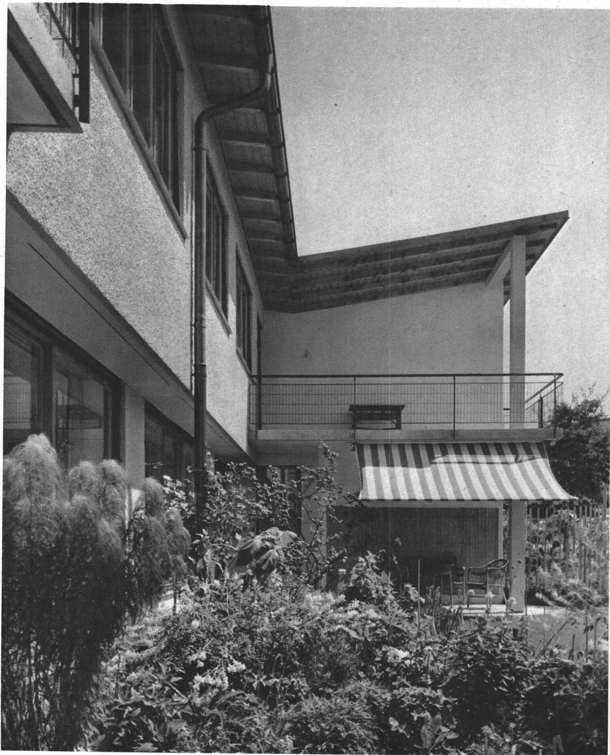
Ansicht aus Südwesten
