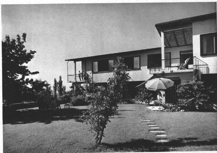
Haus S. in Zollikon Werner M. Moser, Arch. BSA Ansicht aus Süden, Gartenseite
