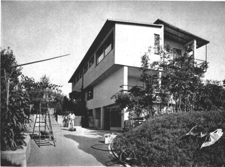
Ansicht aus Westen, Eingangsseite
