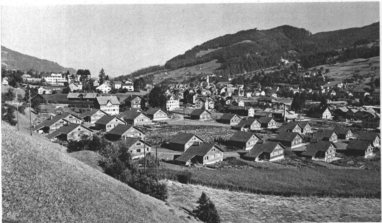
Ansicht aus Süden
