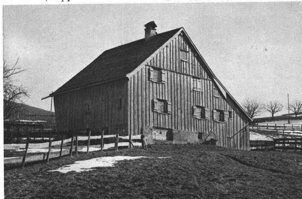
Leistenschirm, Rückfront (Nordwestseite) eines Wohnhauses in Stein, Appenzell. Niederschlagsmenge 1,35 m
