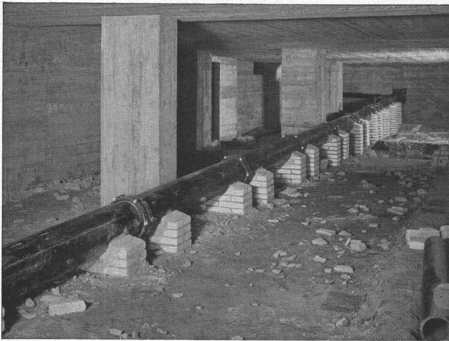
Eine der grossen Ablaufleitungen von 300 mm Ø
