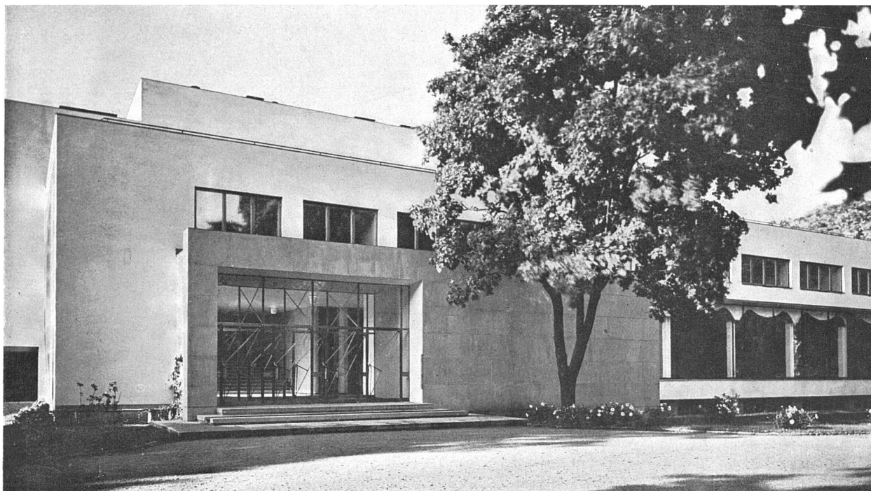
Ansicht von Nordosten und Haupteingang. Fassade in gebrochenem Weiss verputzt, Granitsockel
