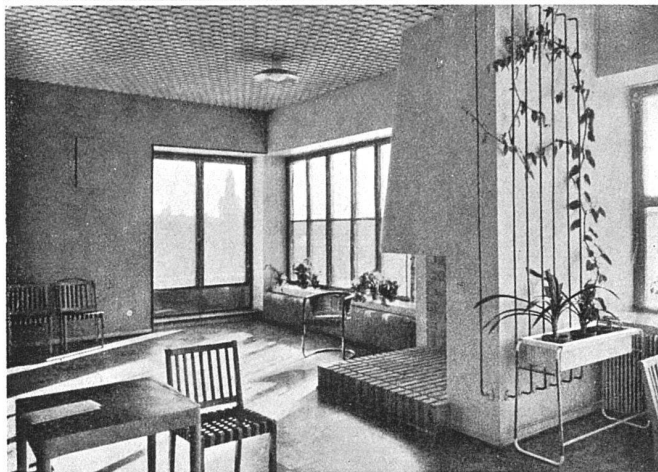
Nebenraum zum Speisesaal des Personals, 7. Stock, mit Cheminée und Ausgang zur Dachterrasse. Deckentextur durch aufgeleimte Insulitscheibchen von 7 cm Durchmesser
