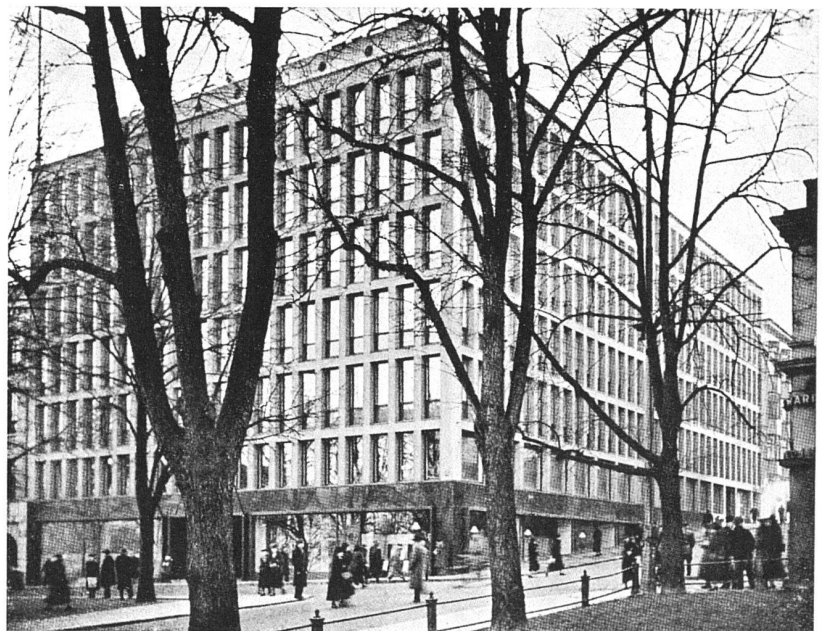
Ansicht von der Esplanade, der Hauptstrasse des alten Helsingfors
