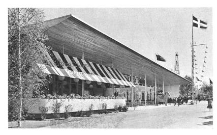
Hauptfassade links Restaurant. Schlanke Stützen aus Stahlrohr mit aufgeschweissten Bandeisen. Untersicht des Schirmdaches in goldbraunem gefirnisstem Kieferholz. Luftspalten zur Ventilation der Dachbinder
