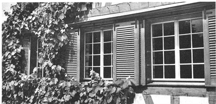
oben: Der erneuerte Giebel mit freigelegtem Fachwerk, darunter neue Fenster mit Schiebläden
