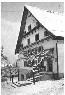
Der erneuerte Glebel mit freigelegtem Fachwerk, darunter neue Fenster mit Schiebladen
