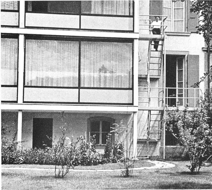
Umbau Arztthaus Dr. W. S., Thun Hans Brechbühler, Architekt BSA, Bern
