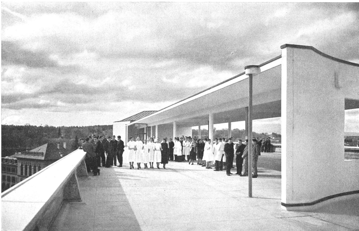
Die Dachterrasse als Pausenplatz, Blick nach Nordwesten
