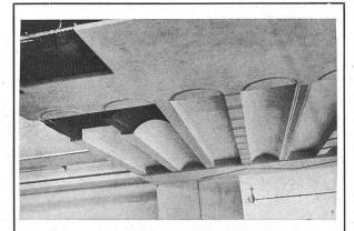
Monieta-Schilfrabitz für rissfreie Gipsdecken Doppelschilfrohrgewebe für Decken und Verkleidungen
