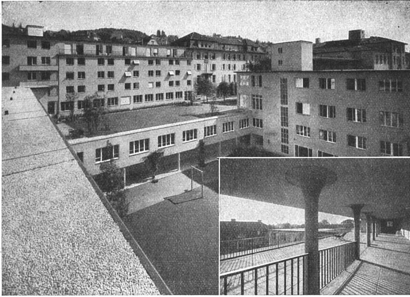
Schweizerische Pflegerinnenschule Zürich Architekten: Gebr. Pfister, Zürich Flachdach- und Terrassenbeläge ca. 4700 m 2 , ausgeführt durch die Asphalt-Emulsion A.-G., Zürich
