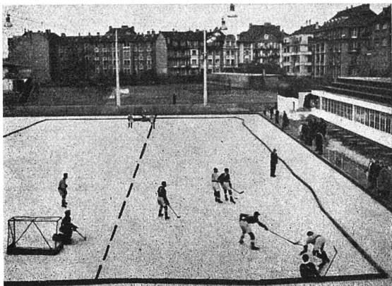
Patinoire artificielle et piscine de Montchoisi, Lausanne
