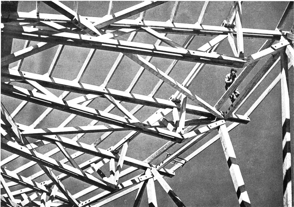
Dachbinder der Halle Strassenverkehr
