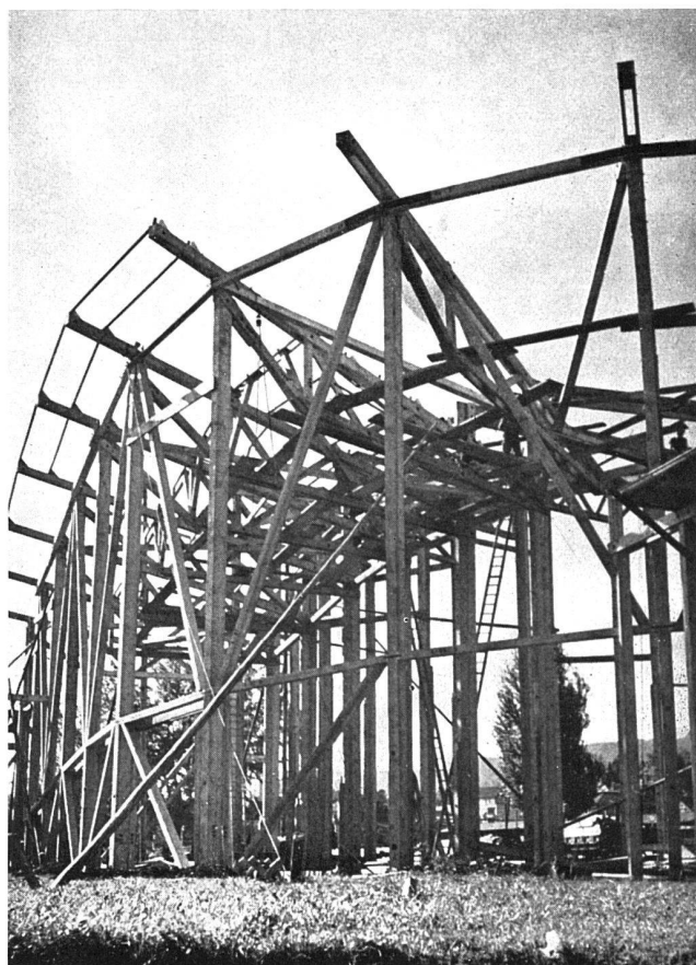
Stockwerksrahmen der Halle Strassenverkehr
