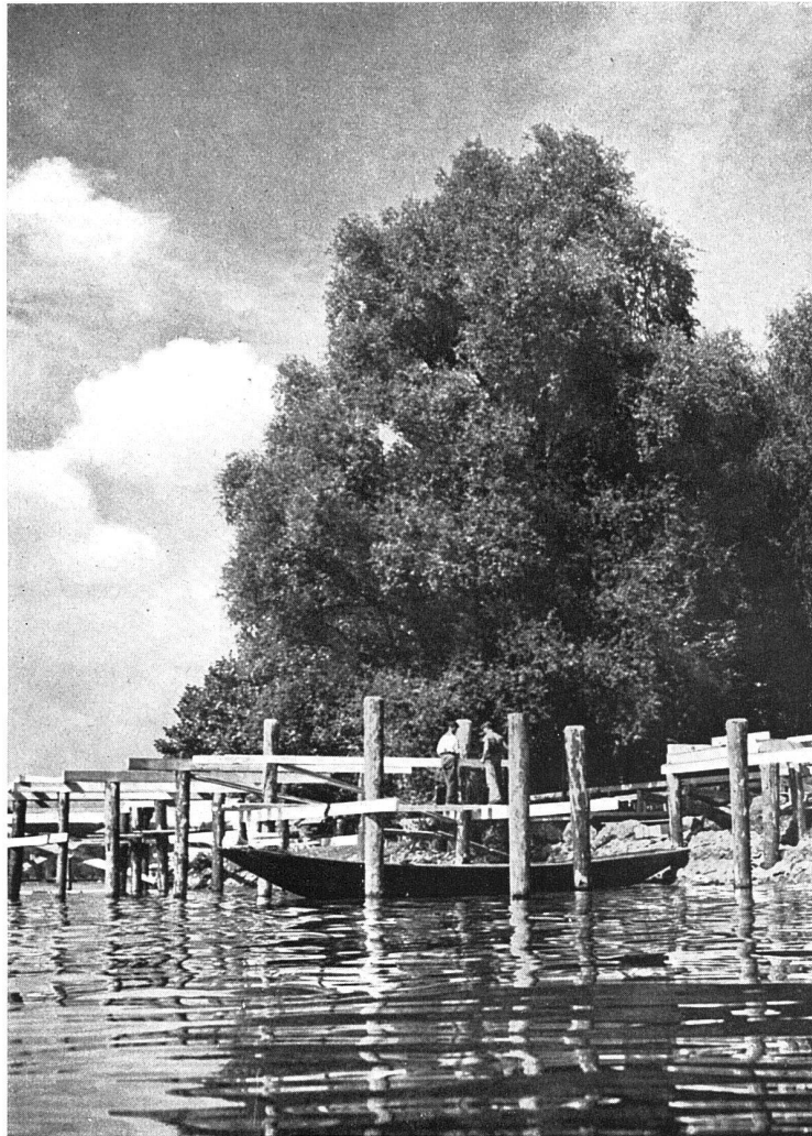
Pfahlrost der «Chüechlistube» am Zürichhorn
