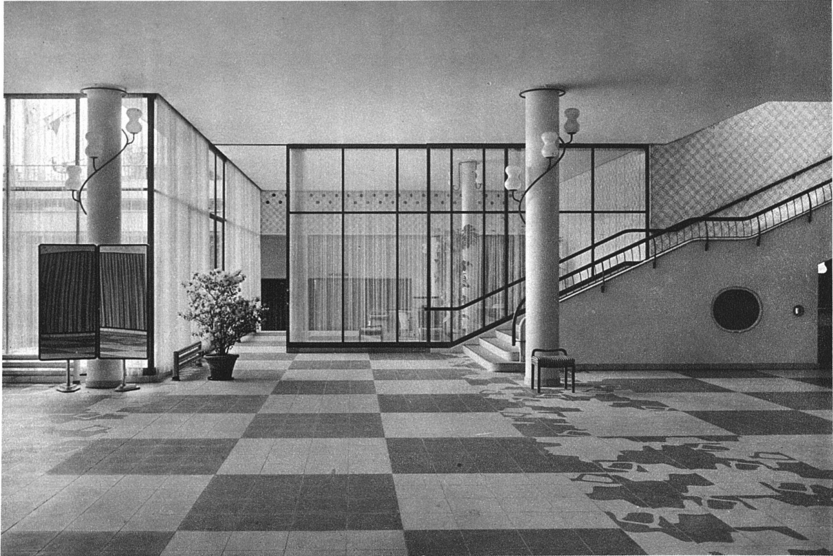
Kongressvestibül, Glasabschluss gegen die Sitznische vor dem Eingang zum Gartensaal und Treppe zum Kongresssaal. Bodenbelag in Kunststeinplatten, zum Teil mit abstraktem Ornament, schwarzgrau und gelblichgrau.
