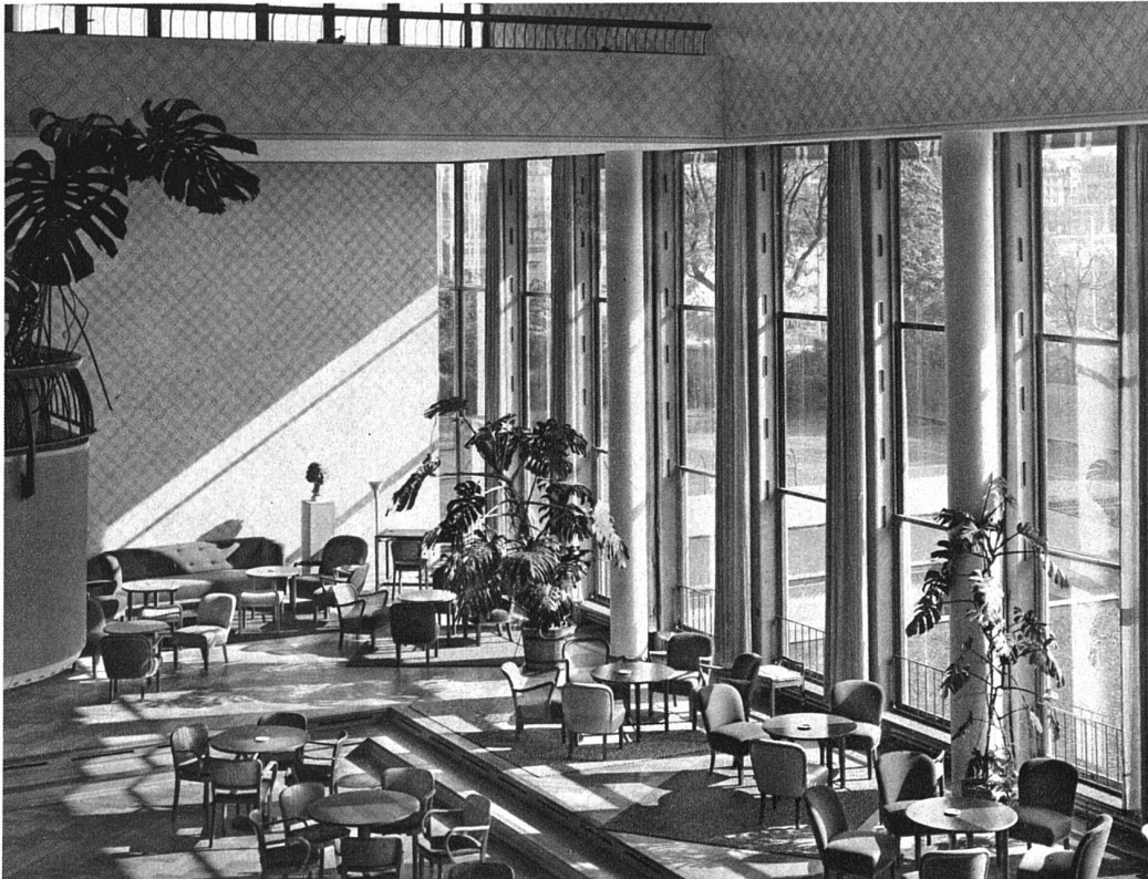
Foyer Ostecke mit Empore und Loggia gegen die Clariden-Strasse. Musterung der Wände in Sgraffito: braune Linien in weissem Putz ausgekratzt, von H. Appenzeller SWB.
