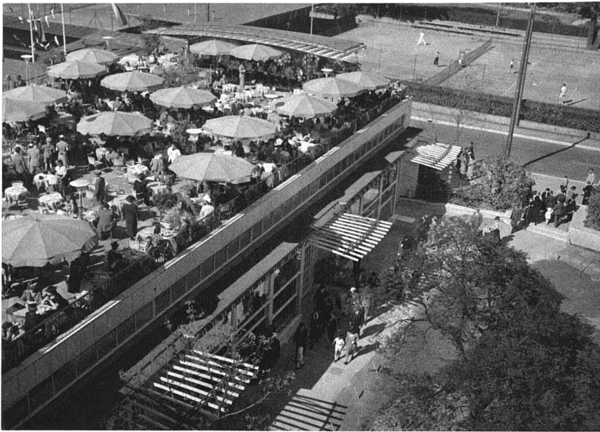
Kongresshaus Zürich. Terrassenrestaurant über dem Gartensaal, am östlichen Kopfe gegen die Clariden-Strasse gedeckte Estrade für das Orchester, gegen den Garten die Lattenvordächer der Eingänge zum Gartensaal, aufgehängt an zarten Gitterträgern (die auf S. 359 sichtbare Bambusrohrung fehlt noch). Die Dachterrasse fasst rund 700 Sitzplätze, der Garten gegen den Alpenquai 500.
