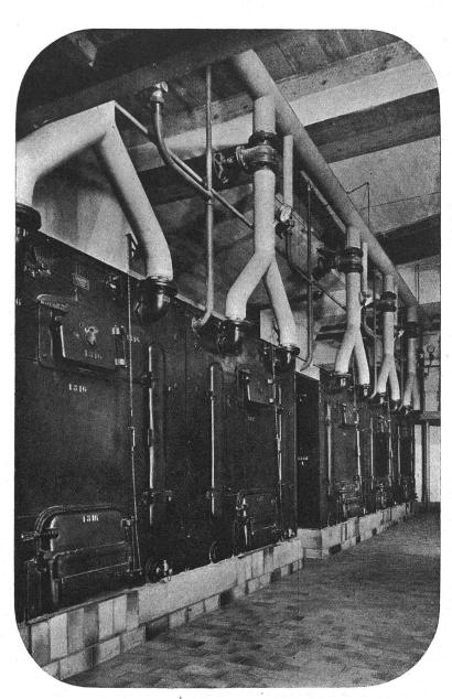
5 Heizkessel Modell Sulzer, ca. 270 m² Heizfläche, hergestellt durch
