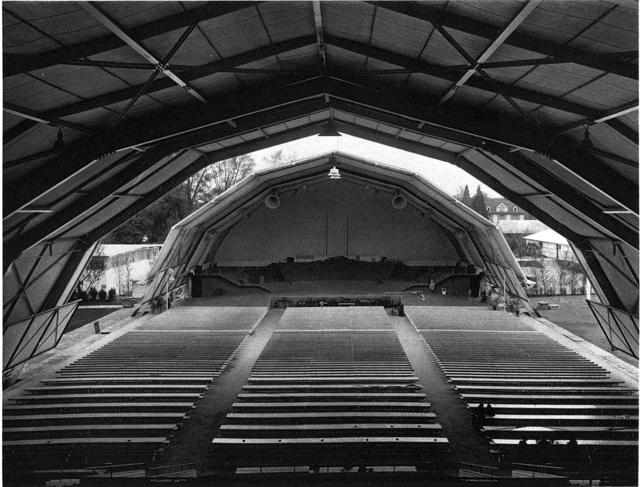
Die grosse Festhalle. Mittelteil teleskopartig über die Kopfteile ausgefahren — La grande Halle des fêtes Breiteabstand der Schienen 44,5 m, Länge der Halle 103 m, Scheitelhöhe 17,7 m
