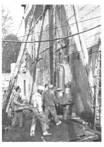
Bohrpfähle (Firma A. Brunner & Co., Zürich) Sie haben den Vorteil, dass beim Bohren die starken Erschütterungen des Rammens unterbleiben, die für die bestehenden Mauern gefährlich wären. An den Bohrpfählen wurde gearbeitet selbst während in den bestehenden Teilen der Tonhalle Konzerte stattfanden
