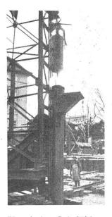
Eisenbeton-Ortpfähle Rammen des Rohres, das dem Beton als Schalung dient und das dann wieder herausgezogen wird (siehe unten links) Firma Losinger & Co., Bern
