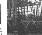
Der trapezförmige Saal weist innen eine Länge von 33 m auf bei 10 m Höhe, grösste Breite 32 m, geringste 20 m. Es waren Erdbewegungen von 9000 m³ erforderlich (Firma Th. Bertschinger A. G., Zürich). Eisenskelett (Eisenbau-Gesellschaft Zürich) mit 430 t Stahl, ausserdem 150 t Rundeisen. Fassadenverkleidung in Kunststein (G. Arnet, Zürich, mit Spezialbeton A.-G. Staad)
