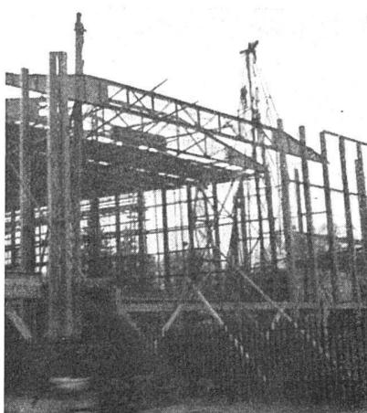
Der trapezförmige Saal weist innen eine Länge von 33 m auf bei 10 m Höhe, grösste Breite 32 m, geringste 20 m. Es waren Erdbewegungen von 9000 m<sup>3</sup> erforderlich (Firma Th. Bertschinger A.G., Zürich). Eisen skelett (Eisenbau-Gesellschaft Zürich) mit 430 t Stahl, außerdem 150 t Rundseisen. Fassadenverkleidung in Kunststein (G. Arnet, Zürich, mit Spezialbeton A.-G. Staad)
