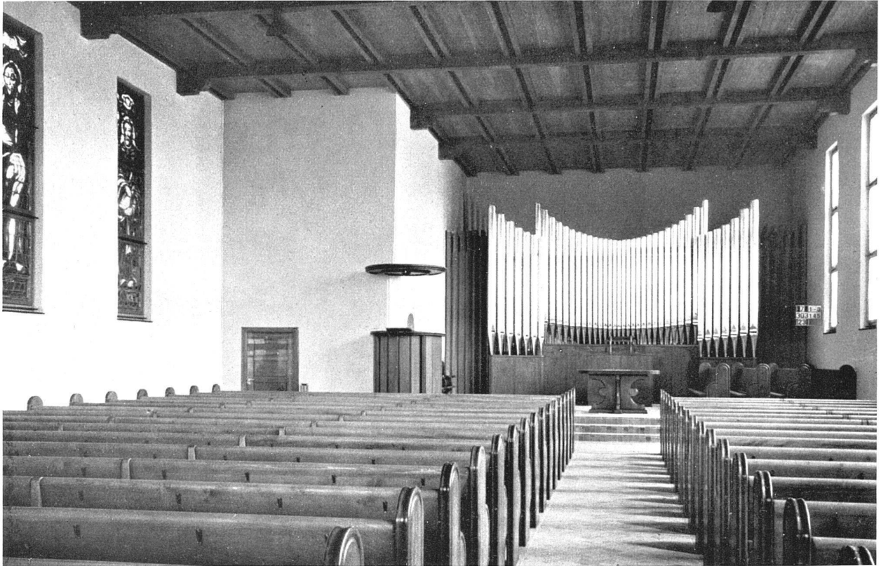
Blick gegen Orgel, Kanzel (Nussbaumholz) und Abendmahlstisch. Bänke aus Tannenholz mit Nussbaumdoggen Dachkonstruktion und Decke in Holz, Gänge mit Lausener Klinkern belegt, unter den Bänken Linoleum Neue Kirche in Schlieren, Kt. Zürich. W. Henauer & E. Witschi, Architekten BSA, Zürich Linke Fensterwand mit den Apostelfenstern von Marcel Poncet, Vich (Kt. Waadt)
