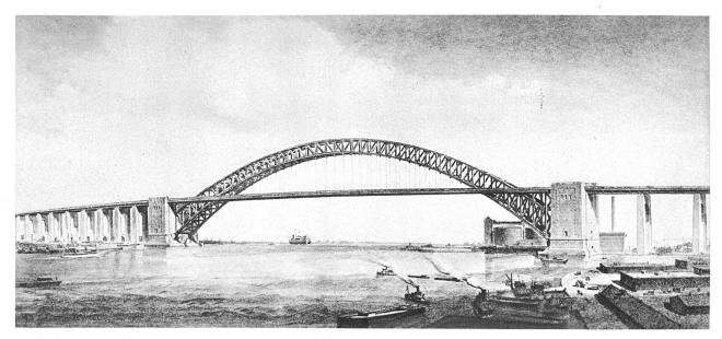
Bayonne-Brücke über den Kill van Kull, New York Erbaut 1926—1931. Bauherr: The Port of New York Authority. Stahlbogen mit einfacher Fahrbahn für Strassen- und Schnellbahnverkehr. Spannweite ca. 480 m, Gesamtlänge mit Zufahrten 2400 m
