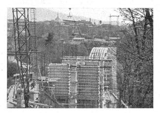
Die eingerüsteten Pfeiler mit Blick auf Bern, im Hintergrund rechts Eisenmast der Montageseilbahn
