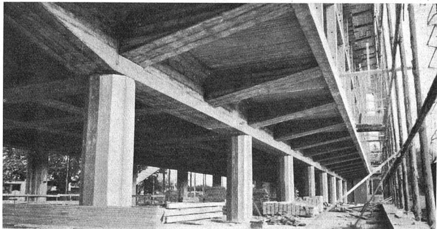
Die fertige Hallendecke wird in ihrer gefälligen Konstruktion auch später roh belassen. Die Hallendecke trägt 7500 t = 75 elektr. Lokomotiven. Maximale Säulenlasten in der Halle 530 t, in den Fundamenten 800 t.
