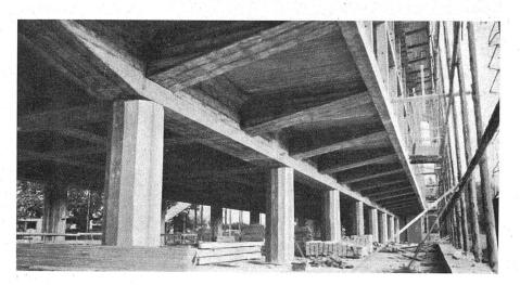
Die fertige Hallendecke wird in ihrer gefälligen Konstruktion auch später roh belassen. Die Hallendecke trägt  $7500~\mathrm{t} = 75~\mathrm{elektr.}$  Lokomotiven. Maximale Säulenlasten in der Halle  $530~\mathrm{t}$ , in den Fundamenten  $800~\mathrm{t}$ .
