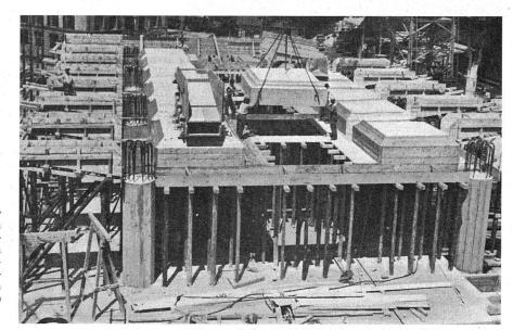
Kassettenschalung für die Decke über der offenen Halle. Den interessantesten Teil des durchgeführten Ingenieurwettbewerbes bildete diese Decke über den sechzehn Säulen. Das erstprämierte Projekt von Ing. W. Siegfried mit Kassettendecke ermöglichte geringe Trägerhöhen und konstruktiv einfache und sinnfällige Auskragung der Längsenden.
