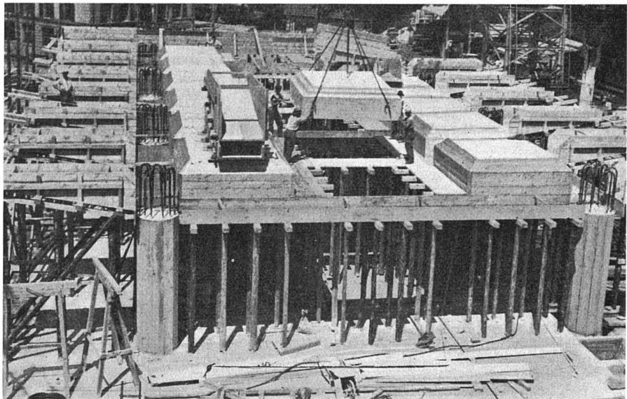
Kassettenschalung für die Decke über der offenen Halle. Den interessantesten Teil des durchgeföhrten Ingenieurwettbewerbes bildete diese Decke über den sechzehn Säulen. Das erstprämierte Projekt von Ing. W. Siegfried mit Kassettendecke ermöglichte geringe Trägerhöhen und konstruktiv einfache und sinnfällige Auskragung der Längsenden.
