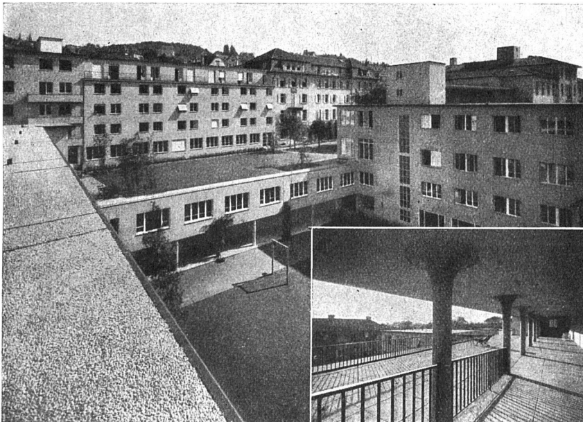
Schweizerische Pflegerinnenschule Zürich Terrassen- und Dachbeläge mit Asphalt- Gewebeplatten «Mammut» Architekten Gebr. Pfister, Zürich
