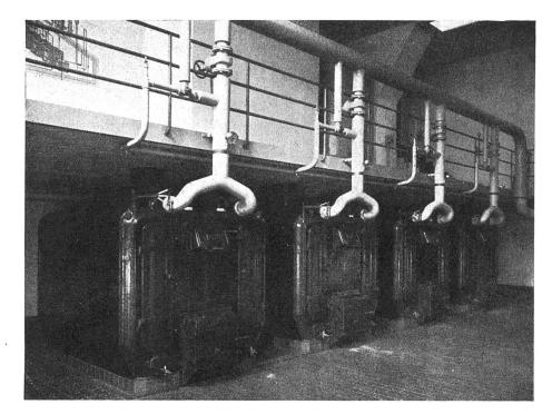
Zürich, neues Amthaus V, Kesselhaus. 4 Warmwasser-Heizkessel ZENT VIII/11 mit total rund 216 m² Heizfläche
