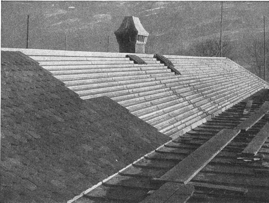
Altersasyl in Näfels Eternitrippen-Unterdach Architekt H. Lampe, Näfels
