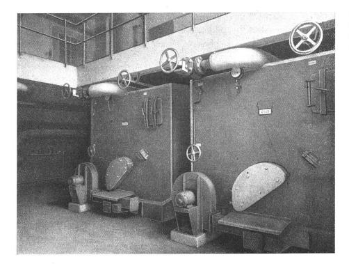
Vento-Kesselanlage in einem Spital, für Heisswasserheizung, zur Verfeuerung billiger, kleinkörniger Brennstoffe
