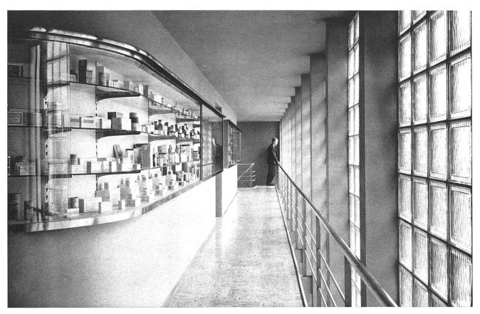
Galeriegeschoss des Sammlungstraktes mit Stahlstützen, Antikorodalschaukasten und Geländer, Gummiboden
