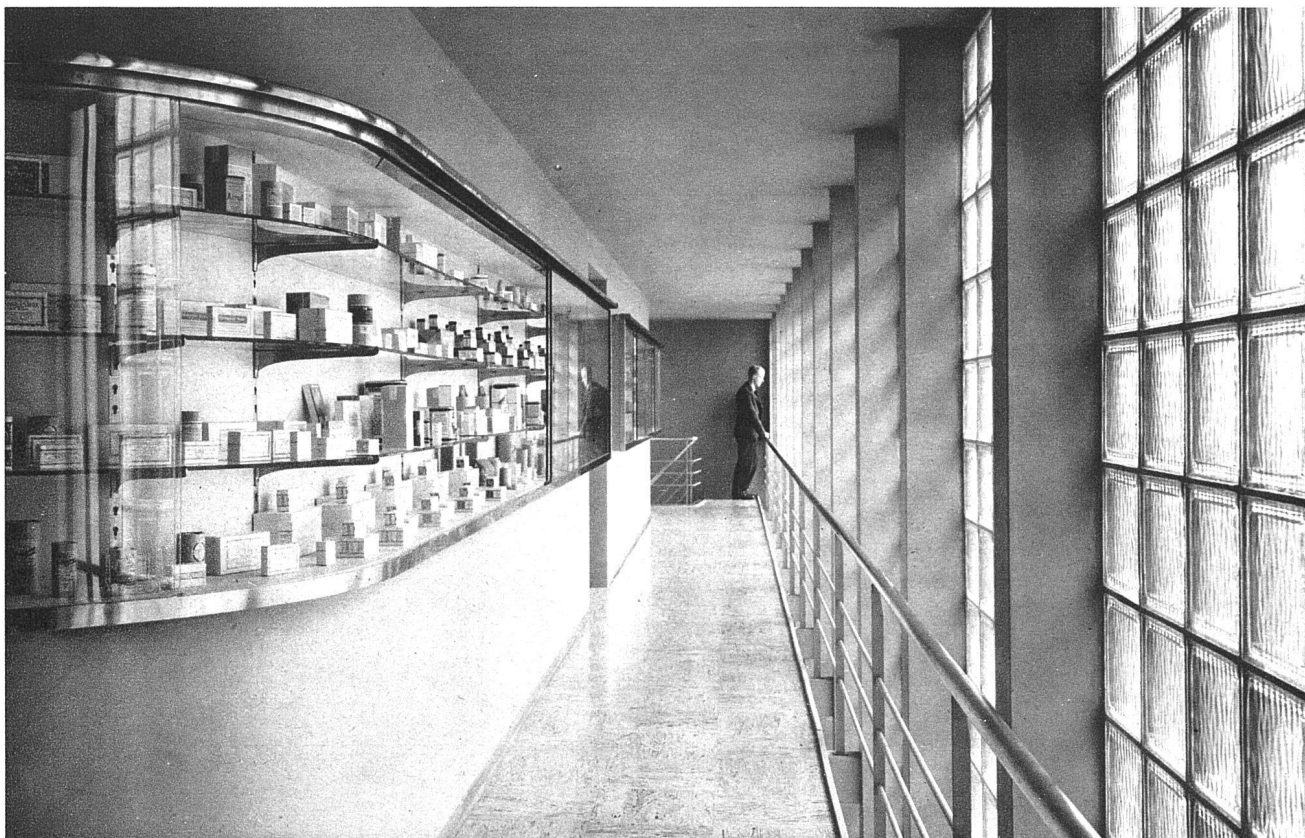
Galeriegesschoss des Sammlungstraktes mit Stahlstützen, Antikorodalschaukasten und Geländer, Gummiboden
