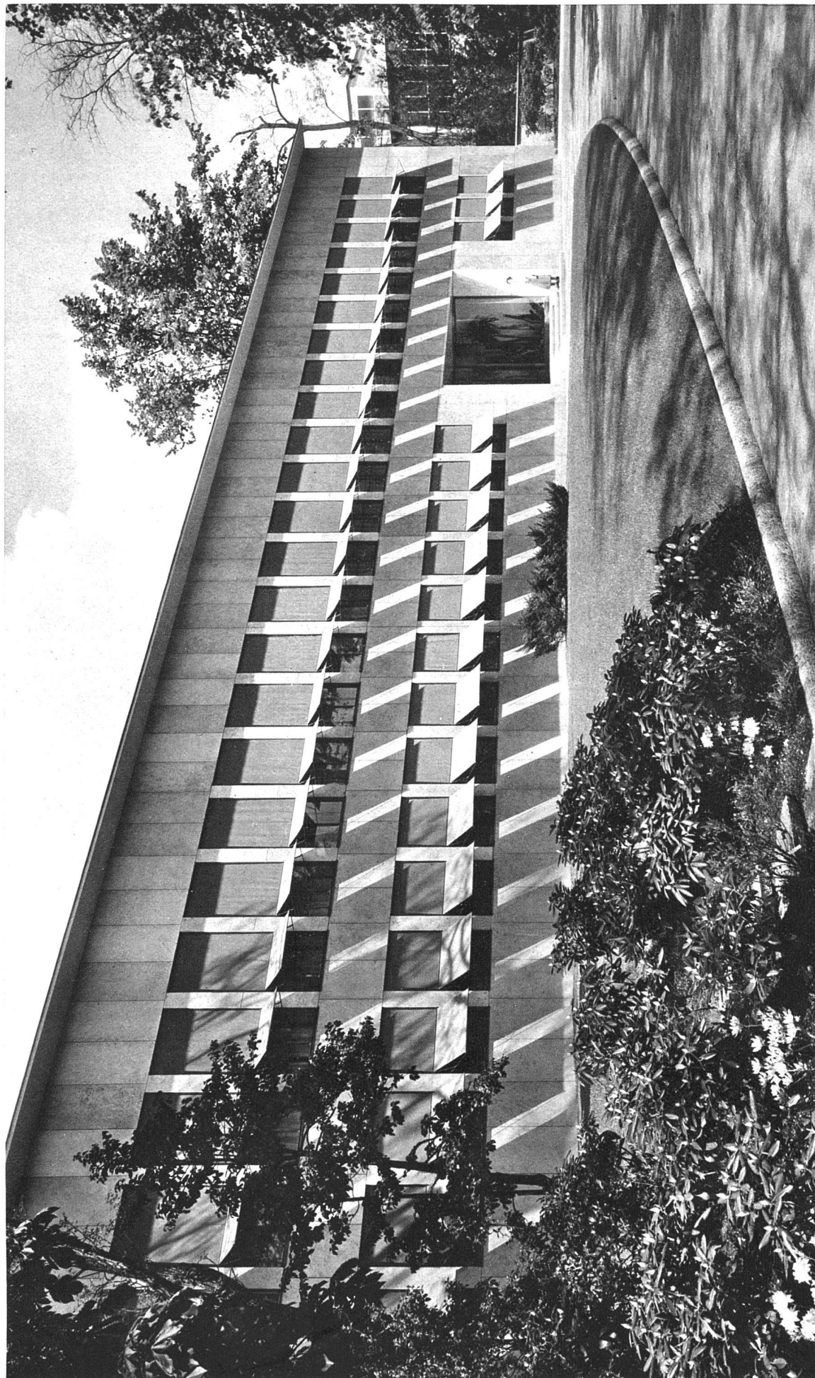
Verwaltungsgebäude der Firma Hoffmann, La Roche & Co. A.-G., Basel Prof. O. R. Salvisberg, Architekt BSA, Zürich Direktionstrakt von Süden her, mit Hauptvorfahrt. Material: Laufener Natursteinplatten, auskragende Betonplatte als Abschluss. Bronzefenster. Kupferdach
