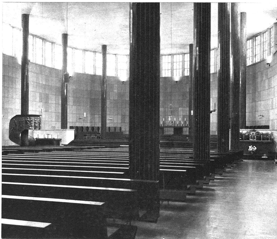
Chor, Säulen verkleidet mit Riemchen aus poliertem Collombey-Marmor
