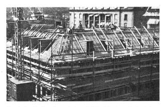
Ein «bodenständiges Bernerdach» mit 20 Dachfenstern. Dachschrägen und obere Dachfläche in Eisenbeton mit Ziegelverkleidung — so baut man in Bern mit dem Beifall des Berner Heimatschutzes
