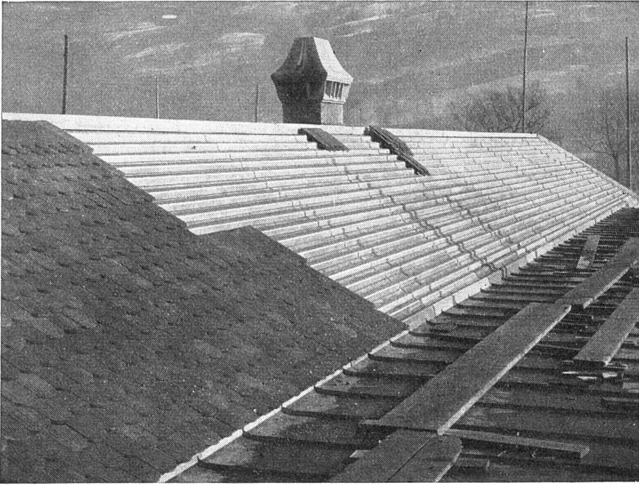
Altersasyl in Näfels Eternitrippen-Unterdach Architekt H. Lampe, Näfels
