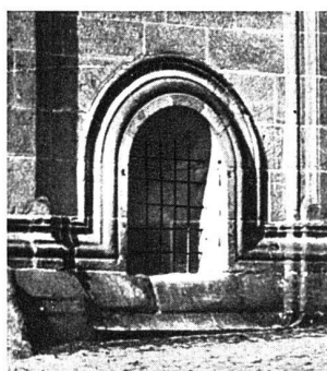
Mangel an plastischem Gefühl, bloss graphische Konturierung der Öffnung, statt Gliederung. Die Sockelprofile verlieren den Sinn einer Schichtung auch für die horizontalen Strecken. Kryptenfenster vom Typus eines «Sockel-Umlaufportals», St. Peter zu Fritzlar (Reg.-Bez. Cassel).
