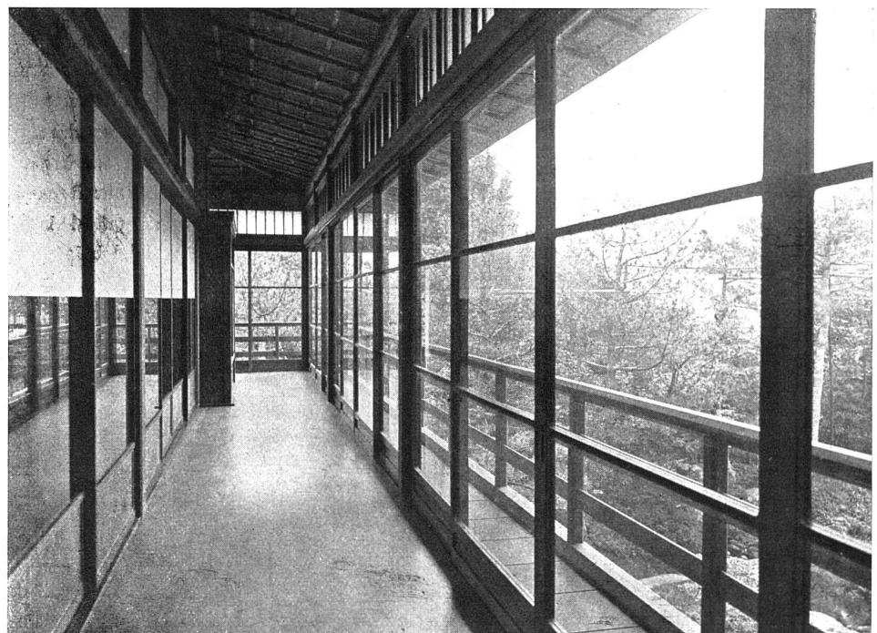
Veranda mit verglasten Schiebetüren im Obergeschoss eines modernen japanischen Hauses
