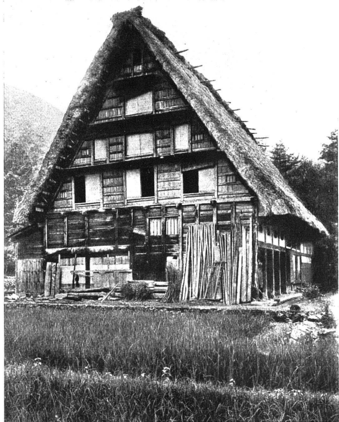
Bauernhaus in der Provinz Gifu. Charakteristisches Beispiel des ursprünglichen japanischen Haustypus. Ständerbau, im Gesamteindruck erstaunlich verwandt europäischen Fachwerkbauten. Wenn das Haus in Europa stünde, würde zweifellos eine Rassenverwandtschaft seiner Erbauer mit den Alemannen vermutet.
