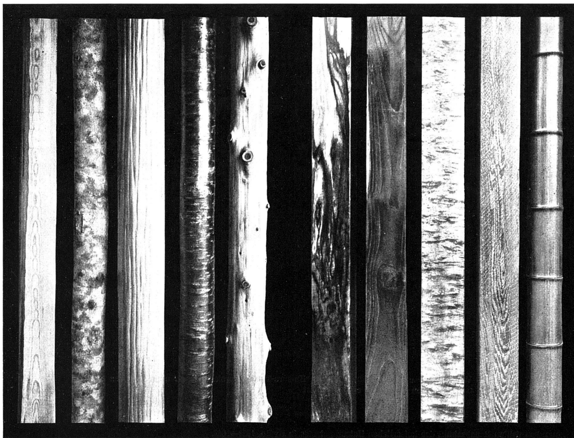
Verschiedene Arten Pfosten vor der Bildernische (Tokonoma) im Wohnzimmer von links: Sugispaltholz, Rundstamm aus Kobushi, poliertes entrindetes Sugirundholz, Kirschbaumrundholz mit Rinde, Hinokistamm mit Astknoten; vierkantige Pfosten aus Kurokakiholz, Ahornholz, Sugiholz, Bambus
