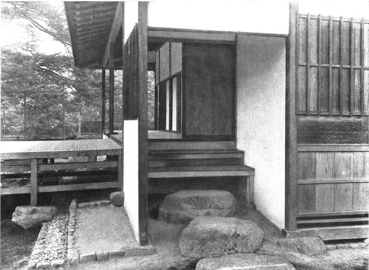
Der kaiserliche Katsurapalast in Kyōto, 1589–1643. Ältester Bauteil mit offener Bambusveranda oben: Detail des Hauseingangs vom Garten und der Veranda
