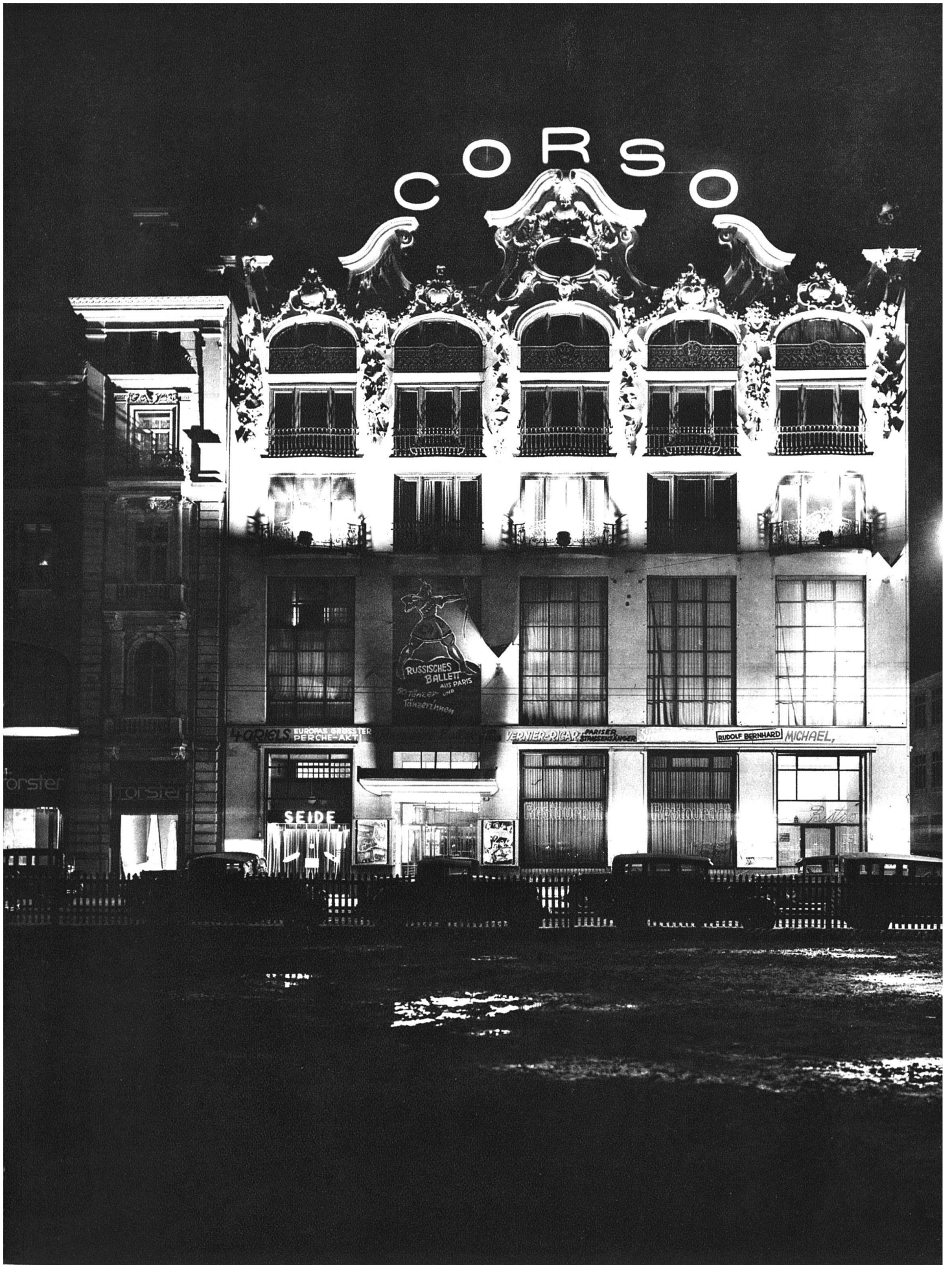
Corso-Theater, Zürich. Umbau durch die Architekten K. Knell BSA, Zürich und Ernst F. Burekhardt BSA, Zürich, 1934 Hauptfassade gegen die Theaterstrasse (Foto Gottfried Gloor, Zürich). Die oberen Geschosse und die phantastische Stuckdekoration des Giebels wurden dankenswerterweise im alten Zustand erhalten; sie entsprechen ausgezeichnet der heiteren Bestimmung des Gebäudes und wirken heute — konfrontiert mit den glatten Formen der Untergeschosse und Anbauten — geradezu surrealistisch. Diese Dekorationen stammen von einem im Büro der Erbauer H. Stadler und E. Uster angestellten tschechischen Mitarbeiter, daher die originelle Mischung von Jugendstil und Prager Barock
