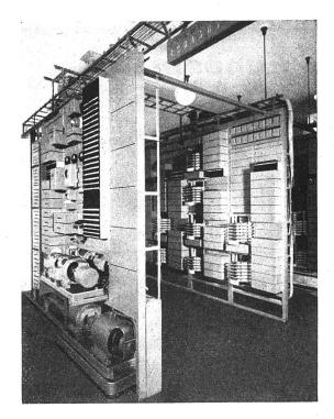
Wir erstellen Telephonanlagen jeder Art und Grösse. Die Abbildungen zeigen die Telephonanlage der Eidg. Technischen Hochschule, bestehend aus dem Vermittlerschrank für 16 Leitungen für den Verkehr mit der Stadt (unten) und dem Automaten für 400 Teilnehmer (oben).
