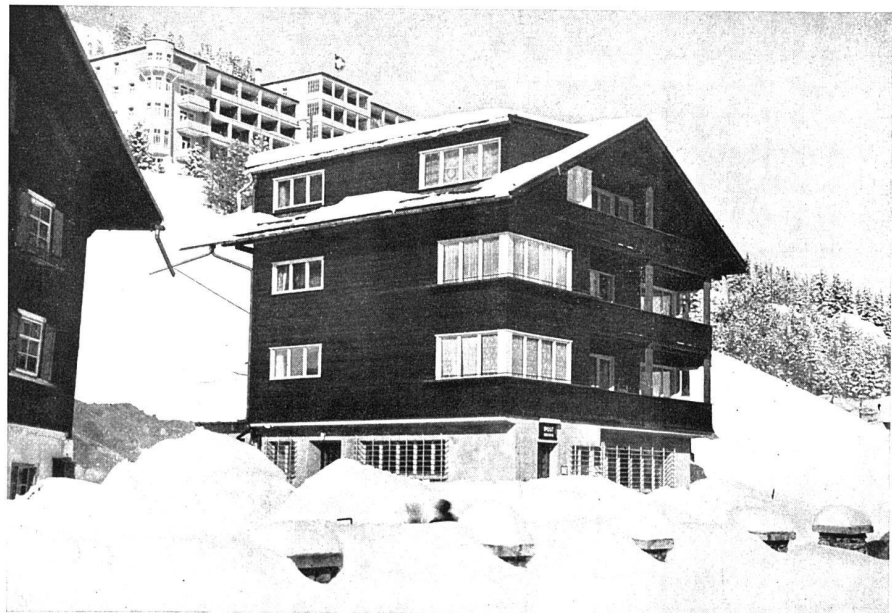
Holzhaus in Inner-Arosa enthaltend das Postbüro und drei Wohnungen J. Licht SWB, Architekt, Inner-Arosa Fotos: Carl Brandt, Arosa
