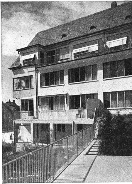
Zwei Mehrfamilienhäuser an der Tobelegg-Ackersteinstrasse Zürich-Höngg. Architekten Kündig & Oetiker, Zürich. (Detail am Haus „Andrea“)
