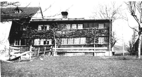
oben: Orientierung der Häuser nach Südosten, die Ställe schützen die Häuser gegen den Westwind Mitte: Die traditionelle Orientierung ist beibehalten, trotzdem das Gelände nach Süden ansteigt unten: «Tätschhaus», sehr flaches Dach. Fensterstreifen gleich hoch wie Brüstungsstreifen
