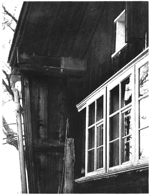
Windschutzwand; die Dachuntersicht besteht aus Balken, nicht aus Brettern
