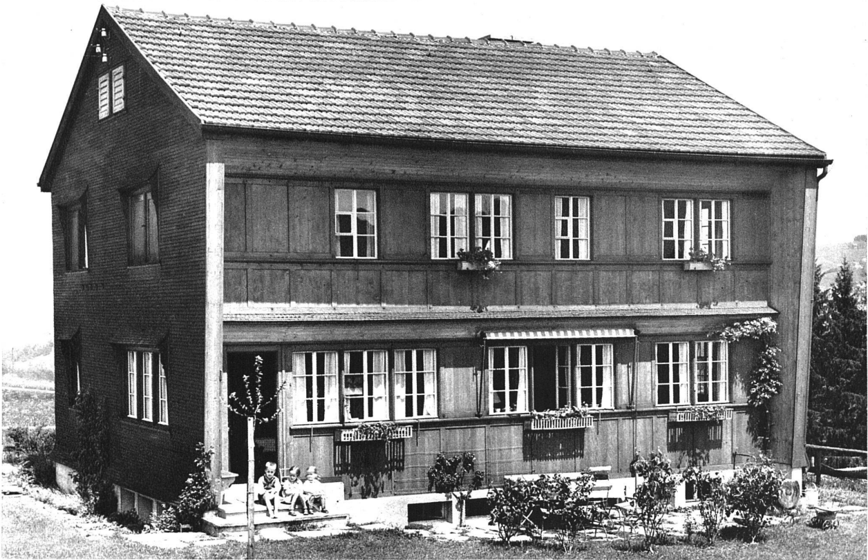
Wohnhaus Dr. Lutz, Trogen, Holzbau, erbaut 1931.
