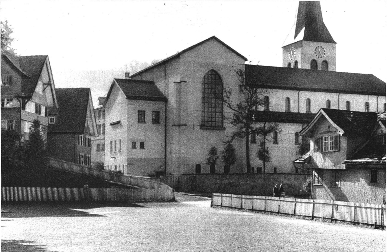
Katholische Kirche in St. Georgen (St. Gallen), erbaut 1931-32.
