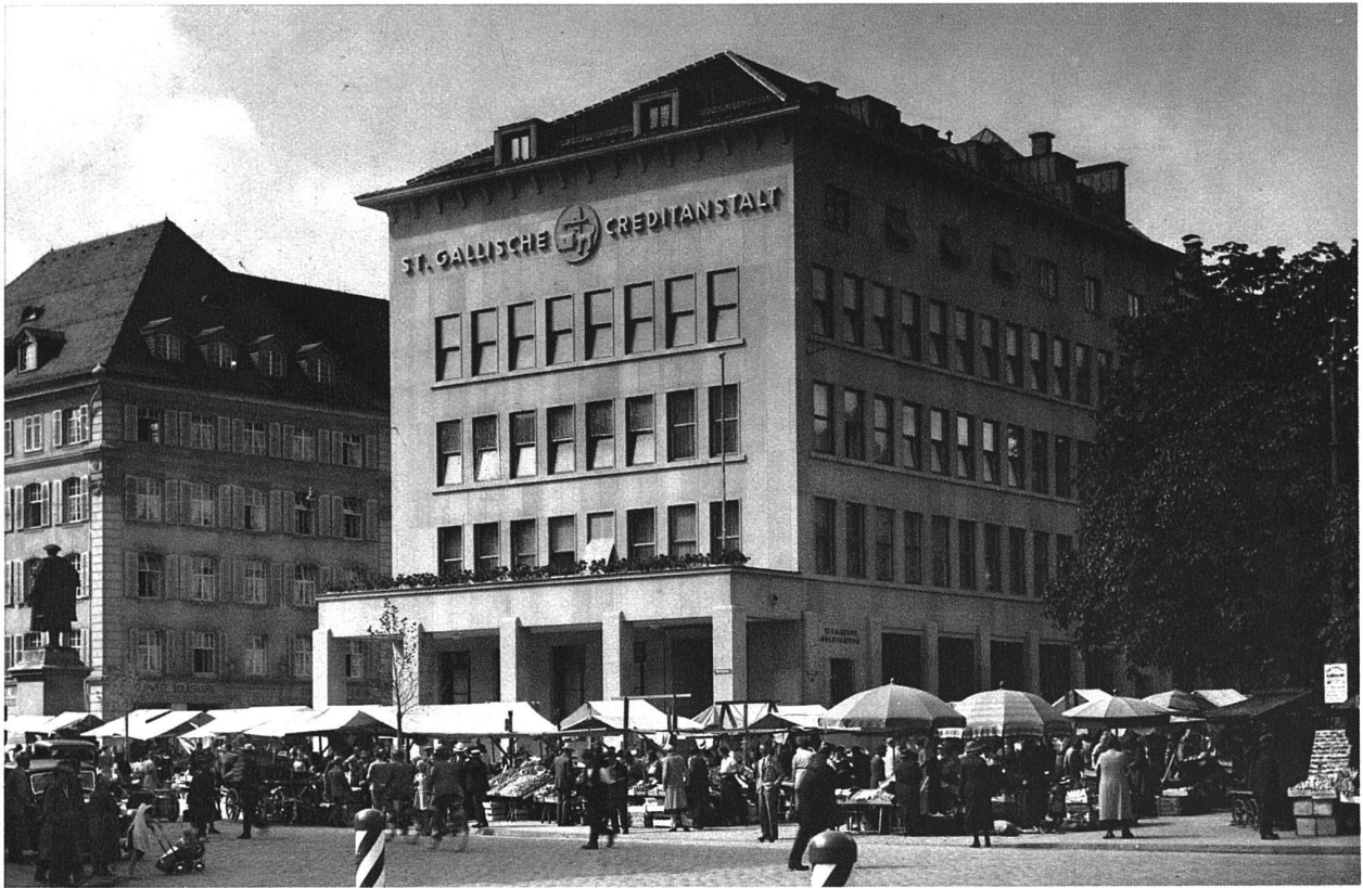
Neubau der St. Gallischen Kreditanstalt am Marktplatz, St. Gallen, erbaut 1934/35. Ansicht von Nordosten
