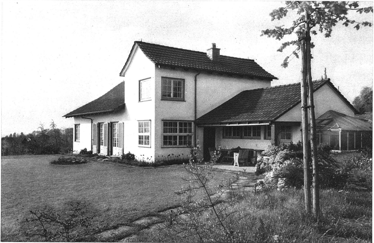
Ansicht aus Südwesten
