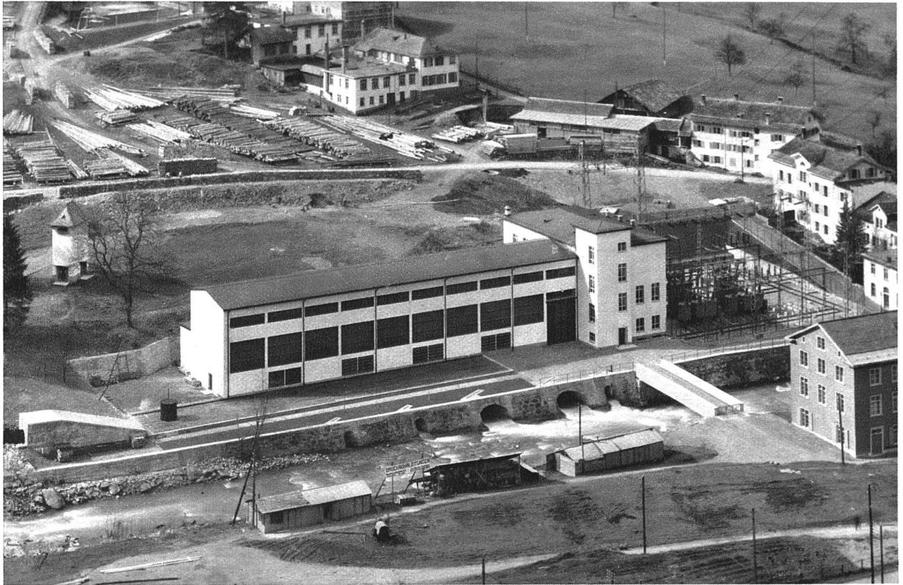
Kraftwerke Sernf-Niedererbach, Zentrale Schwanden, erbaut 1930. Ansicht aus Norden
