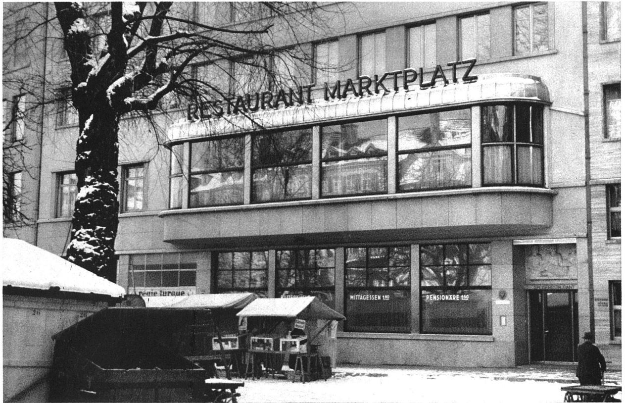
Restaurant Marktplatz der Brauerei Schützengarten, St. Gallen, erbaut 1933/34. Ansicht von Norden
