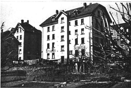
19... Typische Italienerkaserne in Tablat. Zimmer nach Norden. Küche, Aborte, Treppenhaus gegen Süden
