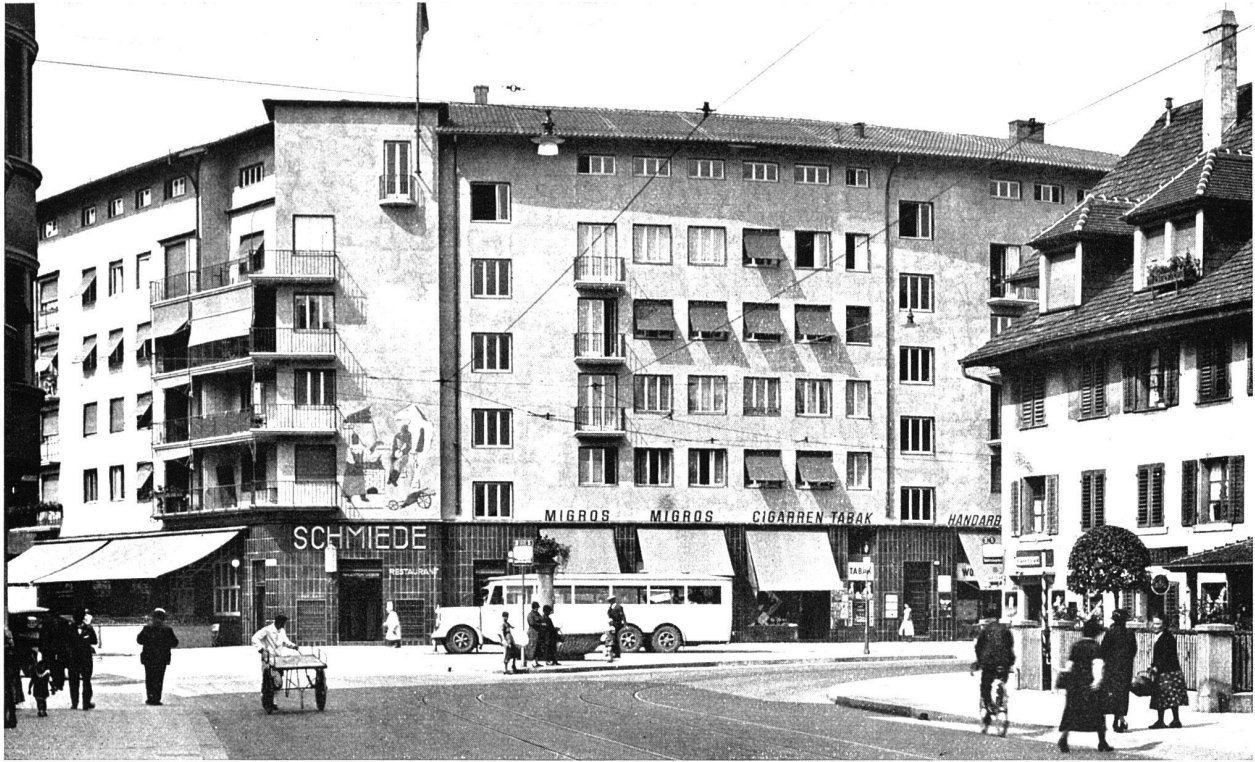
Ansicht aus Nordosten; links Schlossgasse, rechts Birmensdorferstrasse; über dem Eingang Fayencemosaik von Carl Roesch SWB, in Diessenhofen
