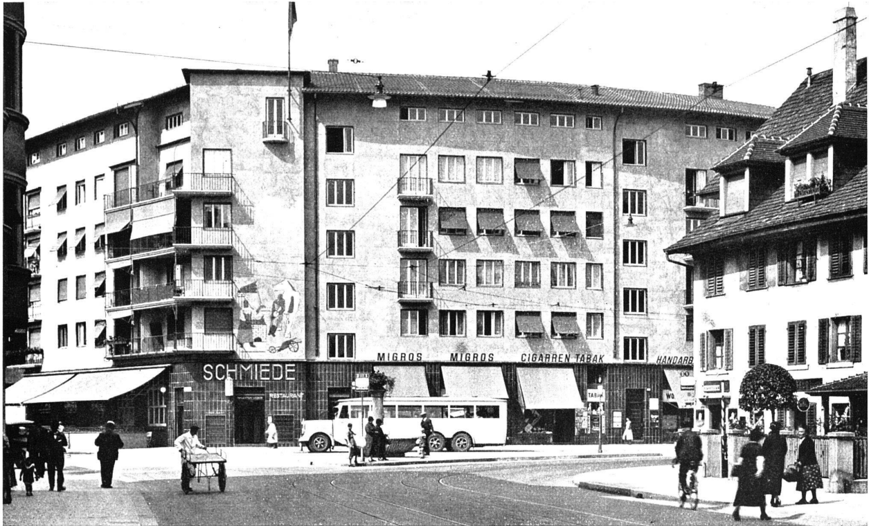
Ansicht aus Nordosten; links Schlossgasse, rechts Birmensdorferstrasse; über dem Eingang Fayencemosaik von Carl Roesch SWB, in Diessenhofen
