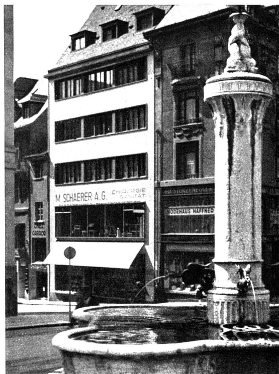
Geschäftshausneubau an der Streitgasse, Basel Eisenskelettbau. Backsteinausmauerung. Fassadenverkleidung in hellgrauen Marbrigitlastafeln. Reine Baukosten Fr. 73.40 per m 2
