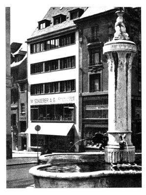
Geschäftshausneubau an der Streitgasse, Basel Eisenskelettbau. Backsteinausmauerung. Fassadenverkleidung in hellgrauen Marbritglastafeln. Reine Baukosten Fr. 73.40 per m³
