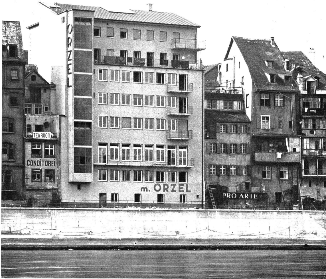
Geschäfts- und Wohnhaus Orzel am Blumenrain, Basel. Rheinfassade, Ansicht aus Osten
