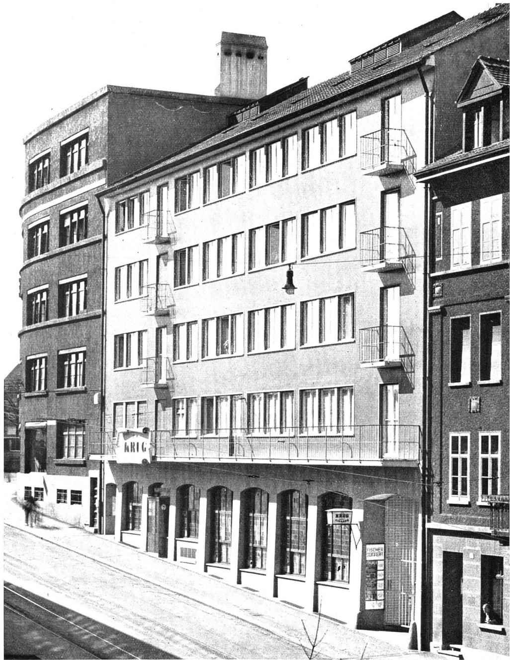
Restaurant «Zum Krug», Basel. Fassade nach der Inneren Margarethenstrasse Bräuning, Leu, Dürig, Architekten BSA, Basel
