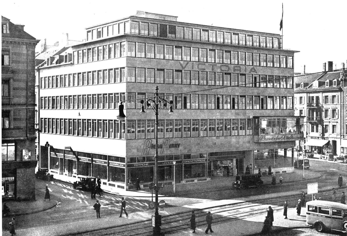
Ansicht aus Nordosten. Ecke Bahnhofplatz-Lintheschergasse
