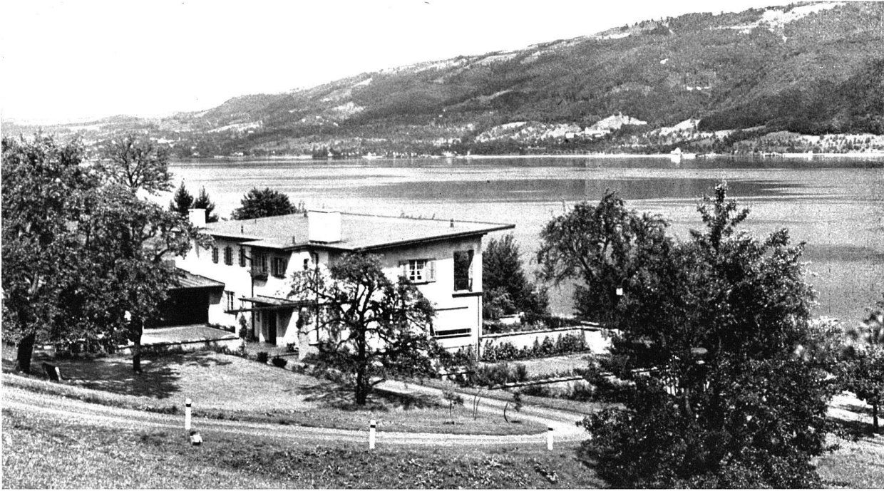
Ansicht aus Südwesten Blick auf den Zugersee
