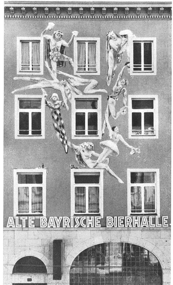
Die «Alte Bayrische Bierhalle», Basel, nach dem Umbau Bräuning, Leu, Dürig, Architekten BSA, Basel
